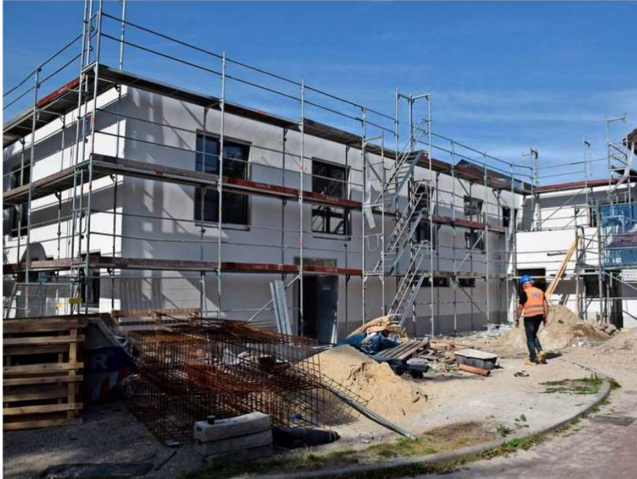
Die Bauarbeiten im und am Seniorenheim gehen in den Endspurt.
